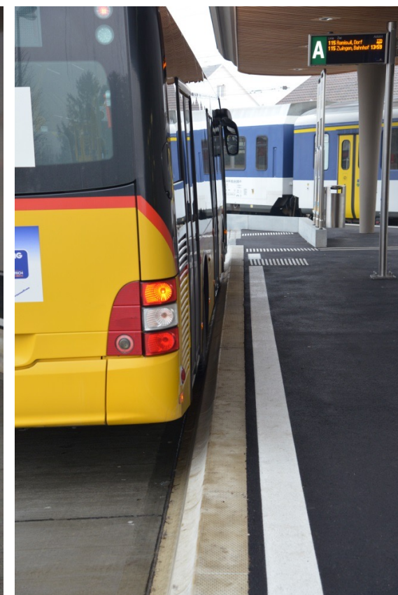
Gare de Balsthal : simplicité des échanges quai-à-quai bus/train ; quais bus aménagés selon les exigences des PMR
